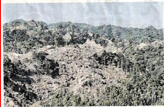
鴨川市のメガソーラーの工事現場—「鴨川の山と川と海を守る会」提供
