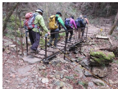
整備された金属パイプの橋 （作るには専門技術が必要）
