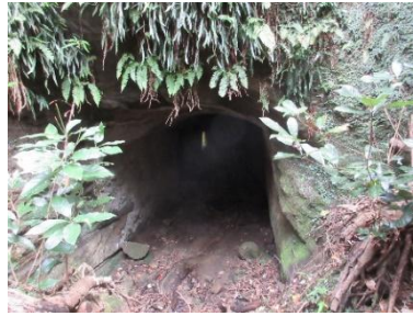
素掘トンネルを通過する
