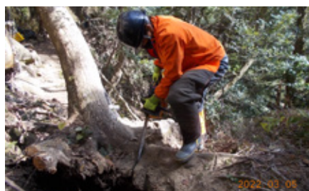
左／関東ふれあいの道（モミ・ツガのみち）。倒木により谷側が崩落し一枚岩になったため、ステップを山側に移設しパイプ支柱を打ち込み手摺養生を設置した 右／郷台林道から300m位、遊歩道上に崩落した木と土砂を除去するための切除作業
