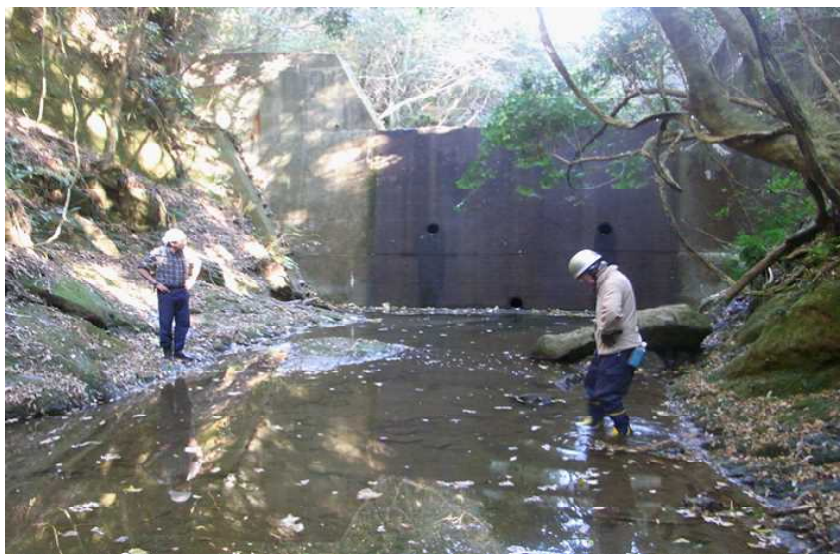
比較的大きなコンクリートで出来た砂防ダム直下
