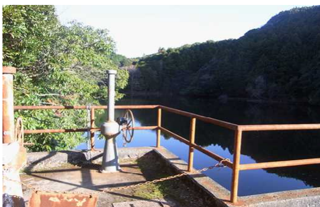
袋倉川第1ダム堰堤から
