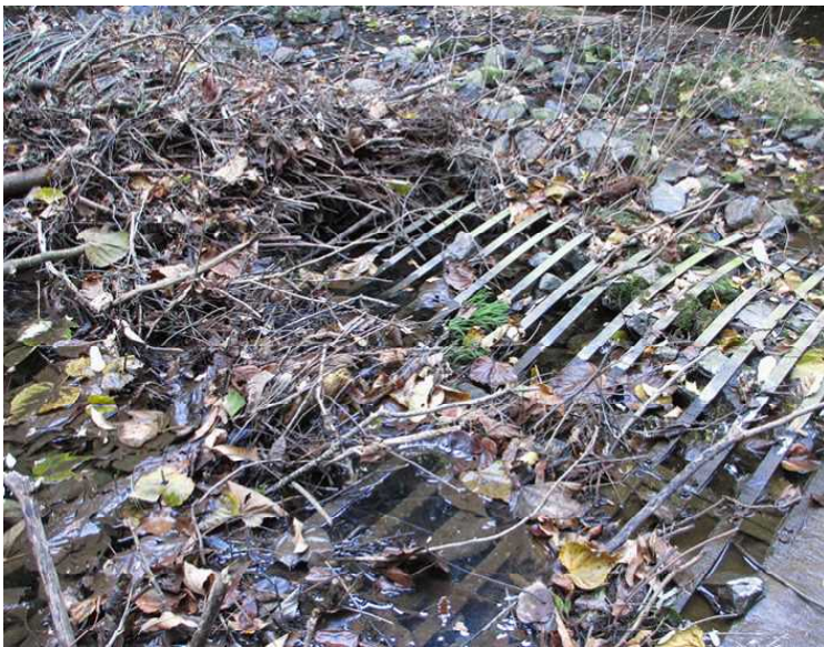
採石ダム直下の様子
