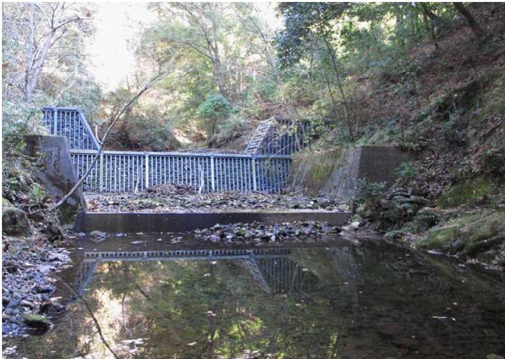
鉄鋼の枠で出来た大きな採石の砂防ダム全景
