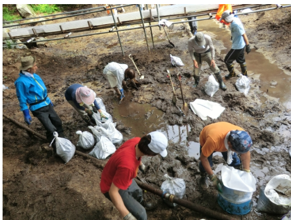
（貯水槽からの土砂の排出）
