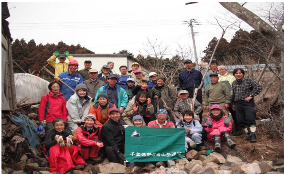
牡鹿 十八成浜 大平宅石垣復旧作業を終えて
