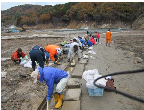
鮫川地区での U字溝の清掃
